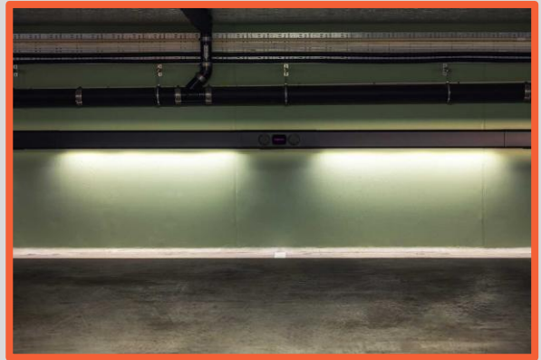
Wihlborgs Immobilien, Malmö in Schweden
